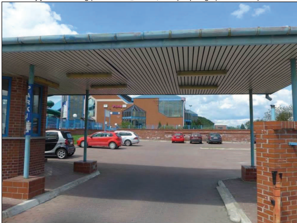
Zdjęcie 6 Parking przez GOK „Perła”, który wymaga przebudowy
