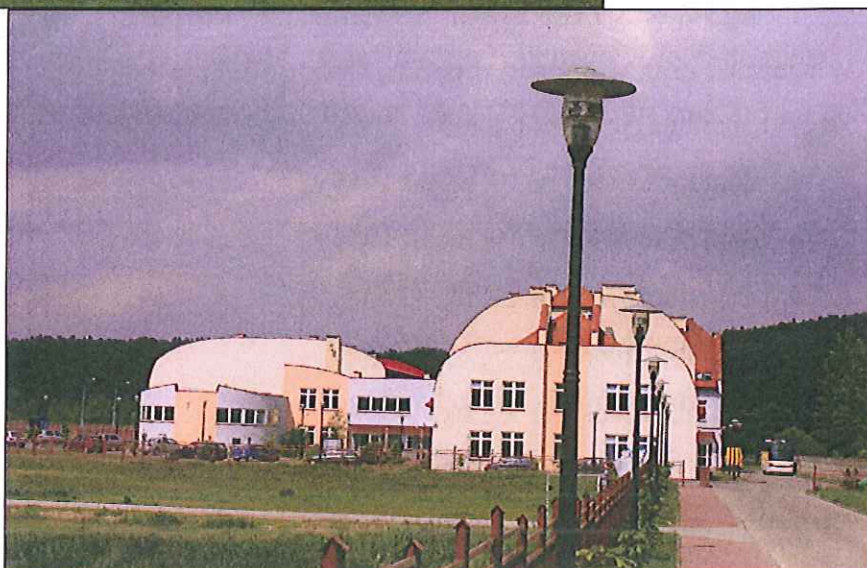
Fot. 4,5. Zespół Szkół Ponadpodstawowych w Zagrodach. Źródło: InicjatywaLokalna.pl
